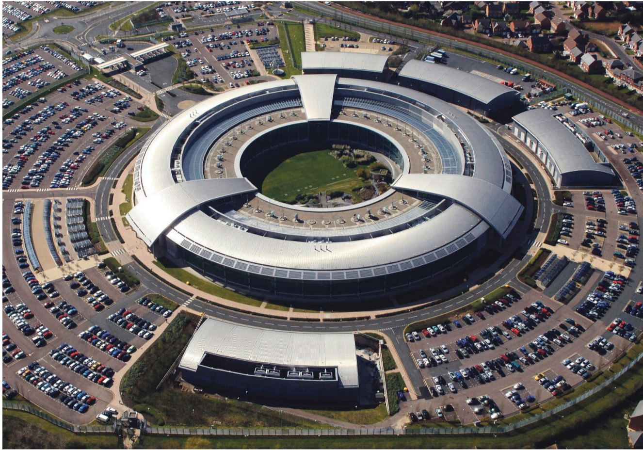
Das Ohr des britischen Geheimdienstes: Die Zentrale von GCHQ in Cheltenham, 130 Kilometer westlich von London. Foto: Keystone
