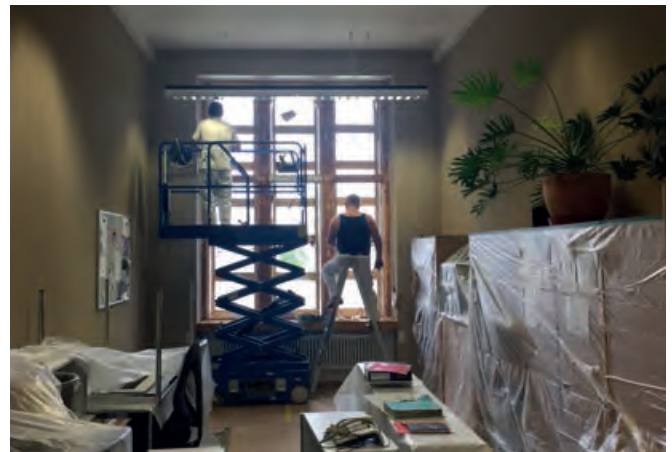
1 Das Büro der Wissenschaftler während des Fensterumbaus (Alexandra Winkler).
