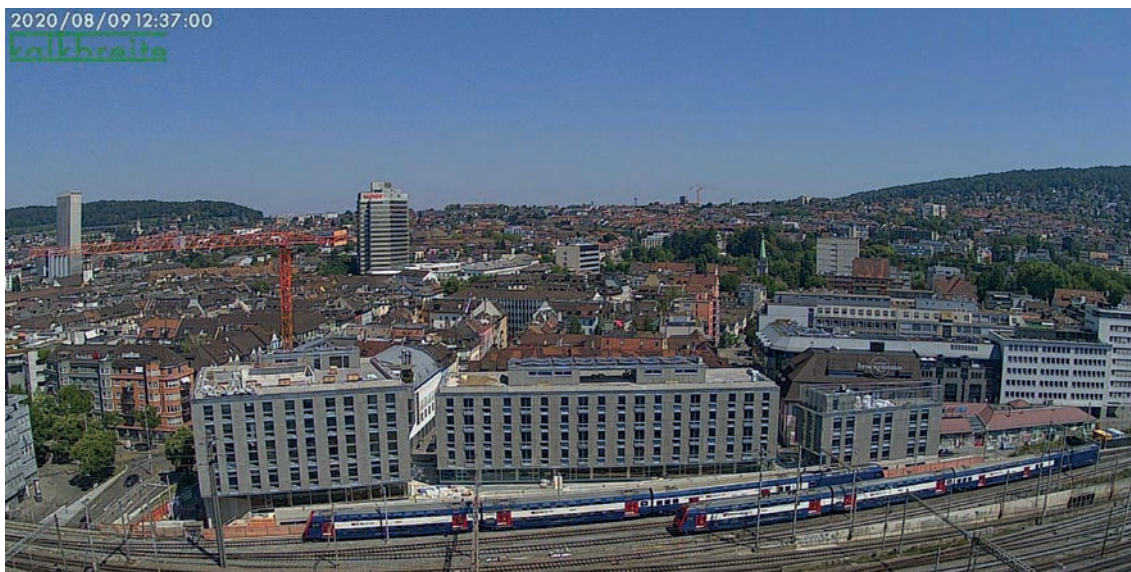
Abbildung 11: Aufnahme Webcam Baustelle Zollhaus (Gefunden unter: https://www.kalkbreite.net/zollhaus/zollhaus-live-cam/ )
