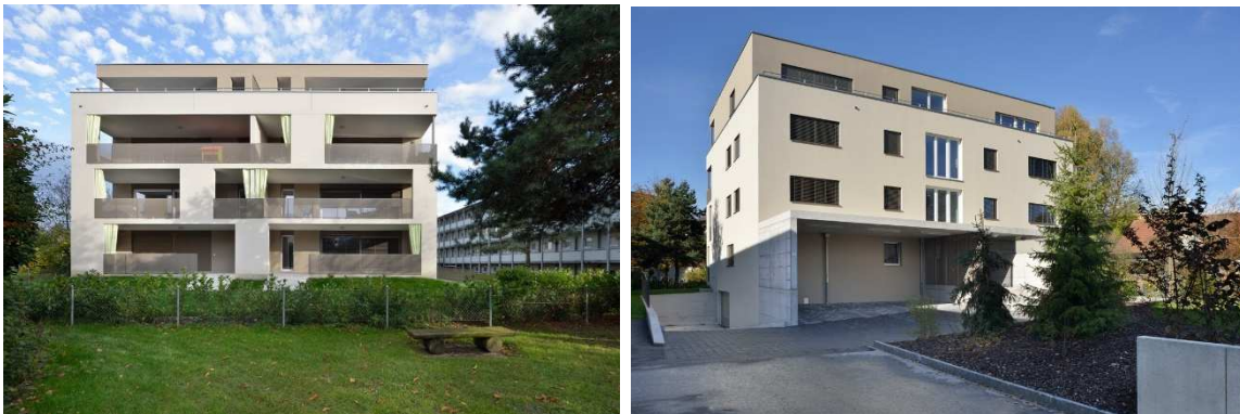
Abbildung 4: Aussenansichten MFH Trattweg 3, Widnau SG (AZ Immobilien, 2018)
