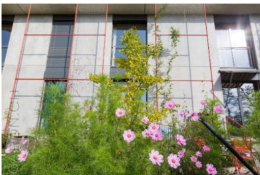
Wohnhaus «Am Wasser» Südseite Quelle: Bernard Garon, 2017 ( www.garon.ch/galerie/zwicky/best )
