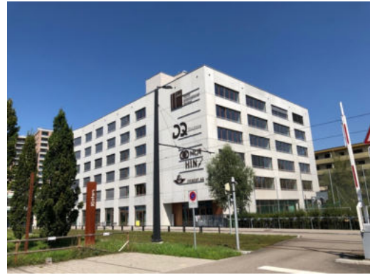
Dienstleistungsgebäude und Schule
