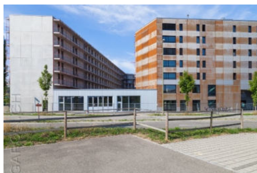
Wohnhaus «Am Wasser» Strassenseite Quelle: Bernard Garon ( www.garon.ch/galerie/zwicky/habitat )
