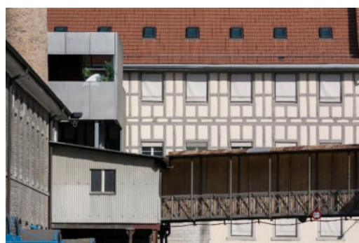
Historische Zwirneriegebäude Quelle: Bernard Garon ( www.garon.ch/galerie/zwicky/habitat )
