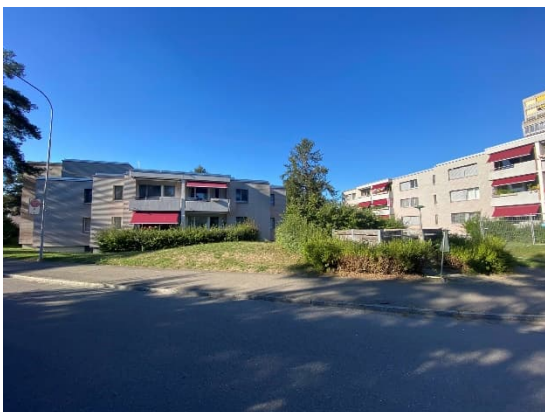
WS Unteraffoltern I (Zugang zu Gemeinschaftsraum WS Unteraffoltern II)
