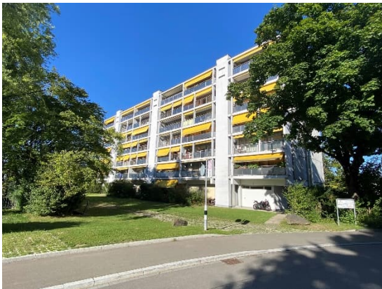
WS Glaubten III (Zugang zu Gemeinschaftsraum WS Glaubten I)
