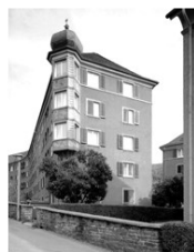
Wohnsiedlung Birkenhof Kreis 6 Unterstrass
