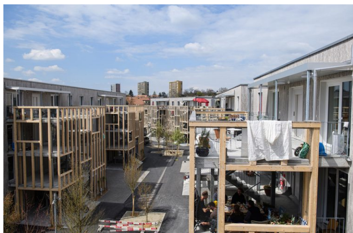
Von Laien sowie Expertinnen und Experten gelobt wurde die Siedlung Huebergass auf der ehemaligen Warmbächli-Brache. Foto: Raphael Moser
