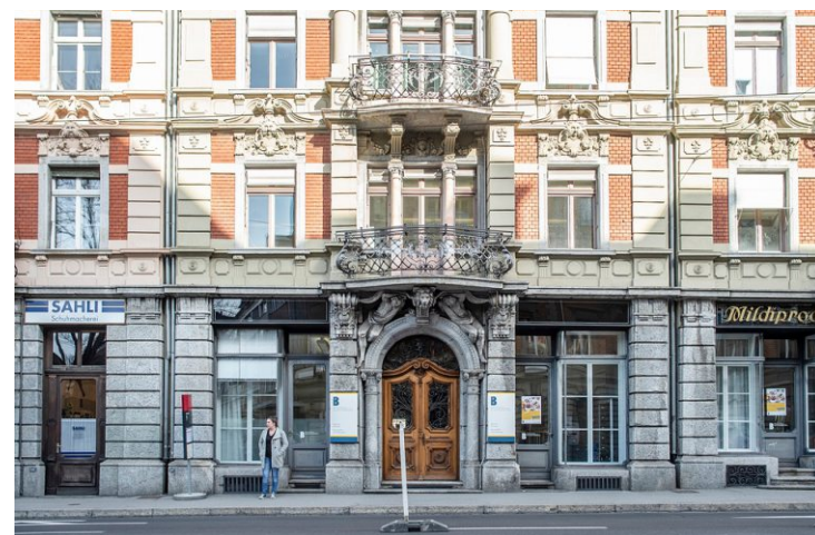
Dieser Bau am Falkenplatz, wo die Berner Fachhochschule Büros hat, zeigt Elemente von Jugendstil-Häusern. Foto: Franziska Rothenbühler
