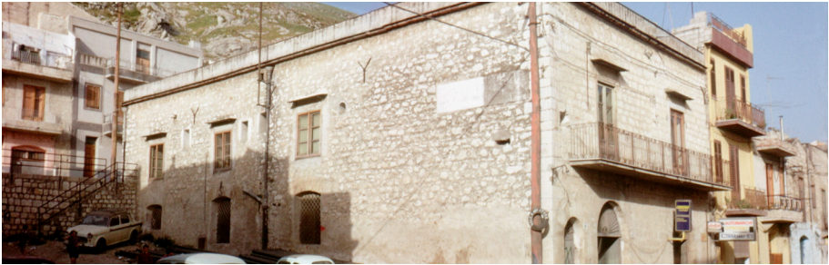
Abb. 3: Das Grabungshaus in der Via Garibaldi von Südwesten.
