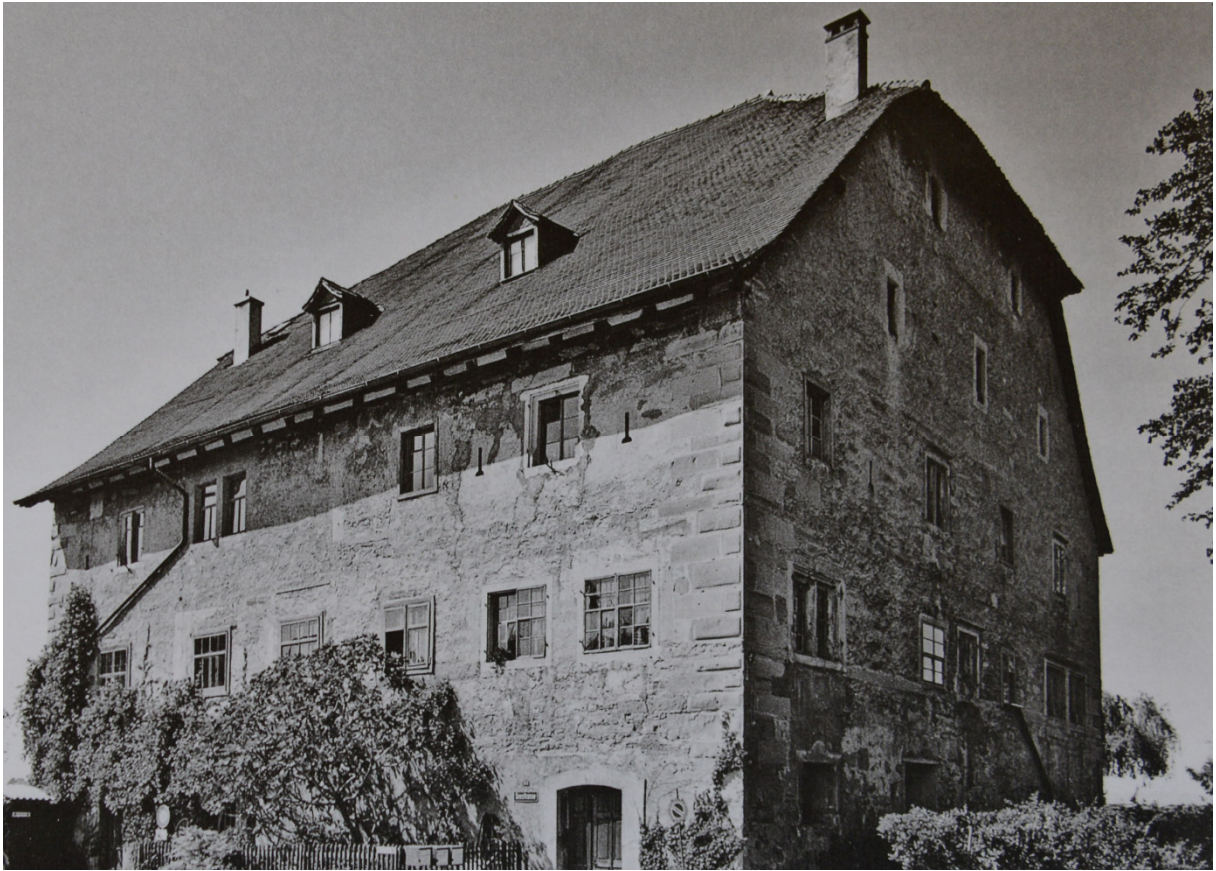
Abb. 10: Im 1473 erbauten Gredhaus in Steinach wurden Güter aufbewahrt, die über den See in die Ostschweiz gelangt waren.
