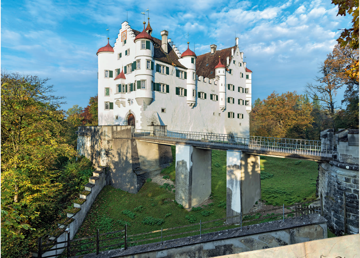
Bild oben: Schloss Altenklingen bei Märstetten TG ist einer der repräsentivsten Landsitze reicher, reformierter stadtsanktgallischer Handelsherren ausserhalb des städtischen Territoriums. Gut zu erkennen ist die Anlehnung der Architektur an mittelalterliche Vorbilder. Aufnahme 2017, Andreas Widmer, Weinfelden.
