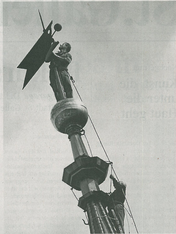
Schwindelerregende Arbeiten an Turmspitze und Turmkugel 1965... Bilder: Stadtarchiv der Ortsbürgergemeinde St. Gallen
