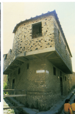
Doppelstöckiges Bordell in Pompeji (Abb. aus Varone 2002, plate 25)
