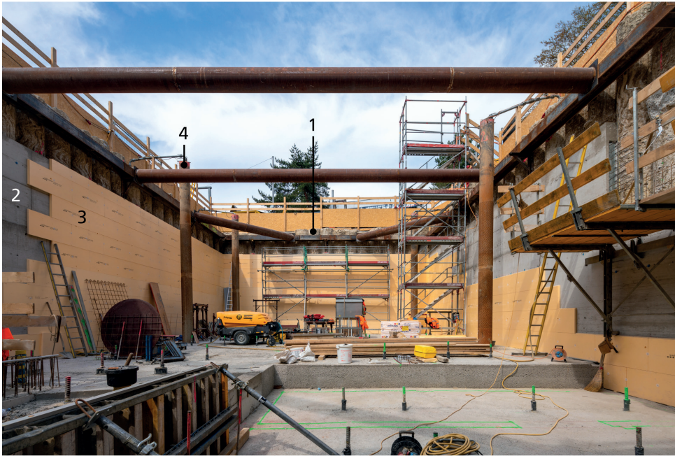
Abbildung 4: Einblick in den Rohbau
