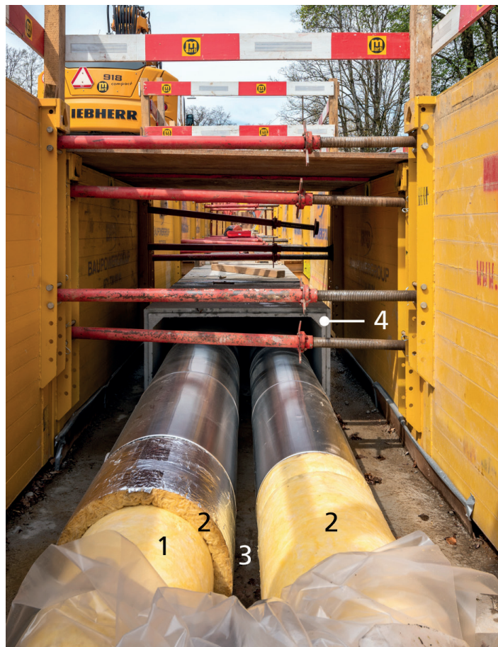
Abbildung 1: Verlegen der Transportleitungen für den Hochtemperaturkreislauf
