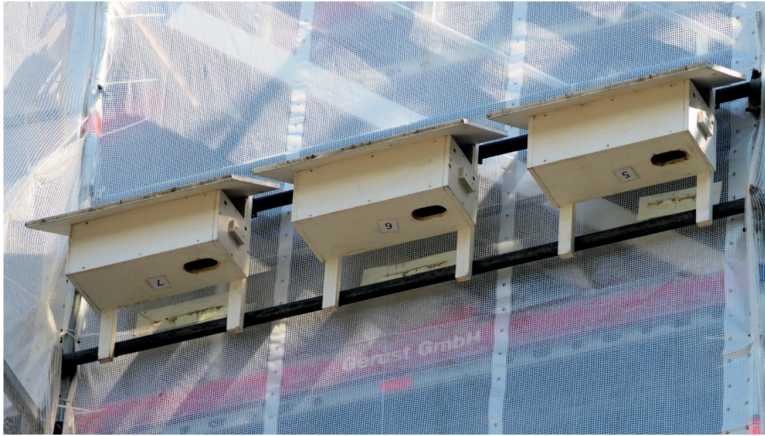
Abbildung 5: Ersatznistkästen am Gerüst des Uni-Hauptgebäudes.
