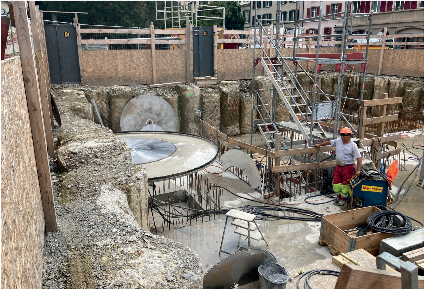
Abbildung 5: Einkürzen der Bohrpfähle damit den Pflanzen überall mindestens 2 Meter Erdreich zur Verfügung stehen.
