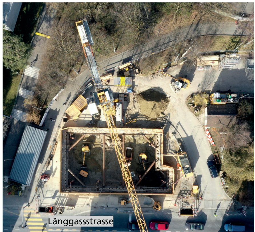
Abbildung 3: Die Baugrube aus der Vogelschau
